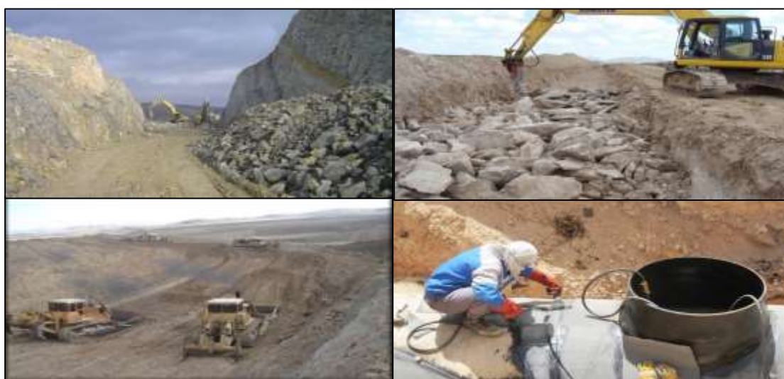
شکل ۵- مستندات از مراحل اجرایی پروژه انتقال آب از سد تالوار به شهر همدان
