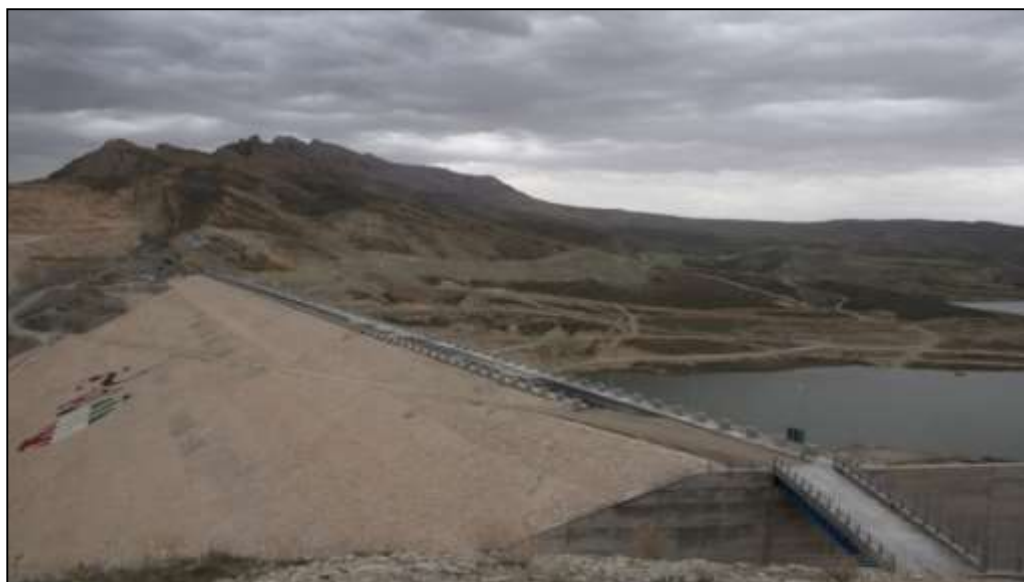
شکل ۴- سد خاکی با هسته رسی احداث شده تالوار
