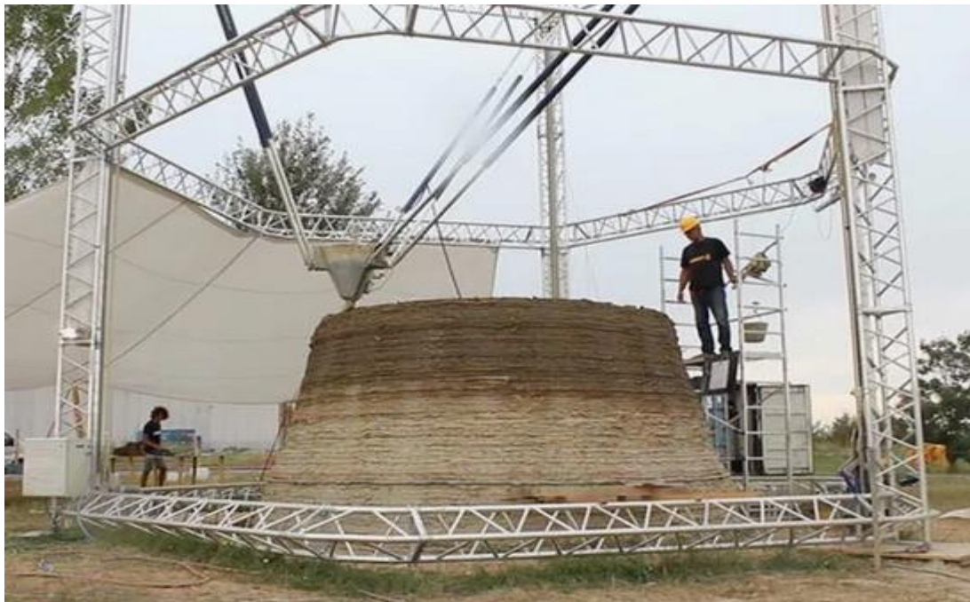
شکل 8. پرینتر سه بعدی شرکت WASP در حال پرینت خانه
