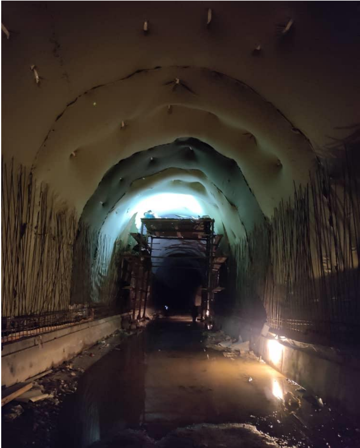
شکل ۳. اجرای سیستم عایق بندی جداره تونل (ژئوتکستایل)
