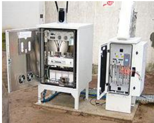
شکل ۱. تجهیزات ایستگاه پایه وایمکس با یک آنتن سکتور و مودم بی‌سیم روی آن
