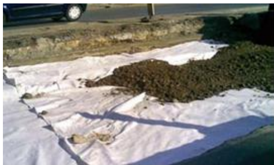
شکل 2. استفاده از ژئوتکستایل برای جداسازی خاک [2].
