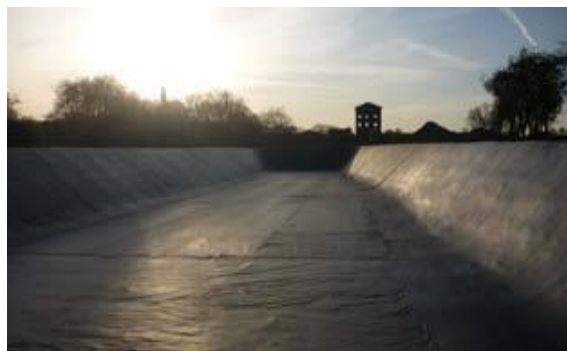
شکل 3. استفاده از ژئوممبرین برای اب بندی کف کانال [2].
