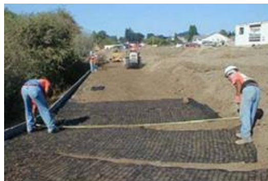
شکل 5. استفاده از ژئوگرید برای خاک مسلح [2].
