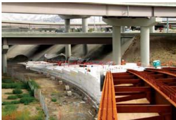
شکل 6. استفاده از ژئوفوم در راهسازی [2].
