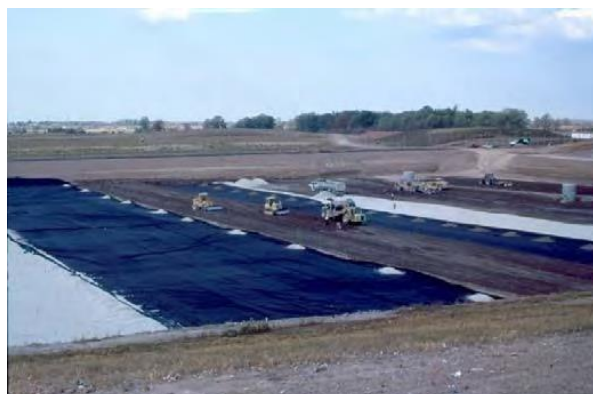
شکل 8. اجرای GCL با ژئوتکستایل در محل دفن پسماند [4].
