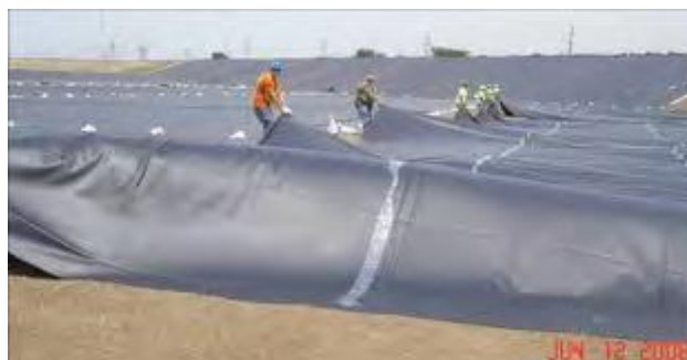
شکل 9. اجرای GCL با ژئوممبرین برای محل دفن پسماند [4].
