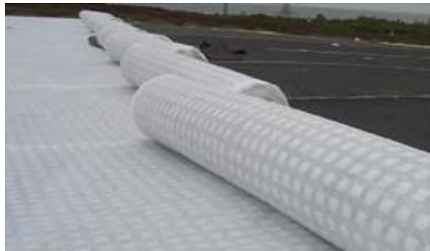
شکل 10. اجرای GCL با ژئوممبرین و ژئوتکستایل برای محل دفن پسماند [4].
