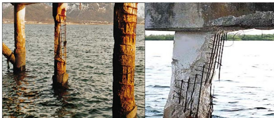
شکل-5- خوردگی دریایی بتن بر اثر تهاجم یون های خورنده حومه خلیج فارس
