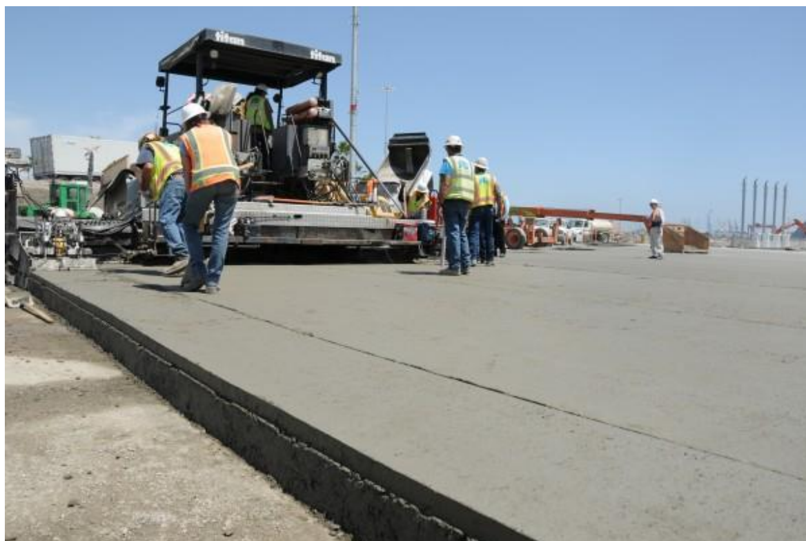
شکل ۳ - نحوه اجرای روسازی بتن غلتکی
