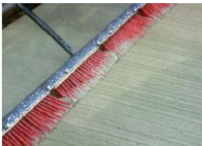
شکل 6- کشیدن برس روی بتن تازه
