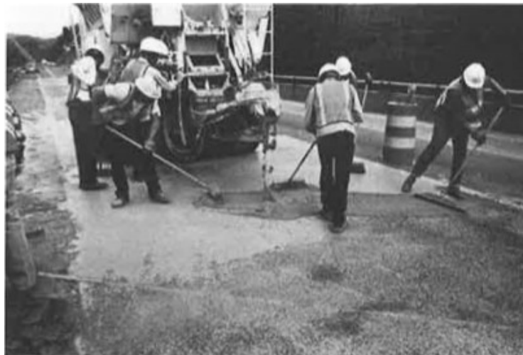
شکل 8- اجرای دوغاب اصلاح شده با لاتکس
