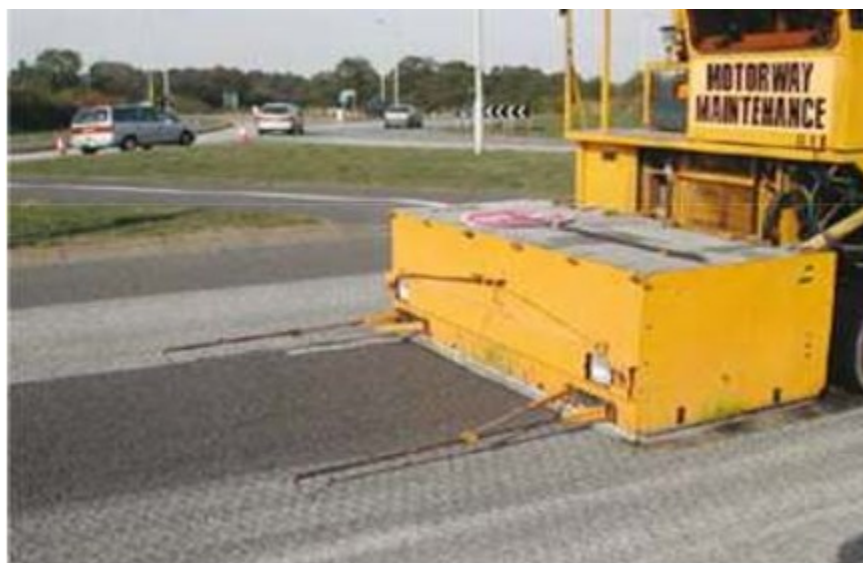
شکل 12- چکشی کردن رویه بتنی
