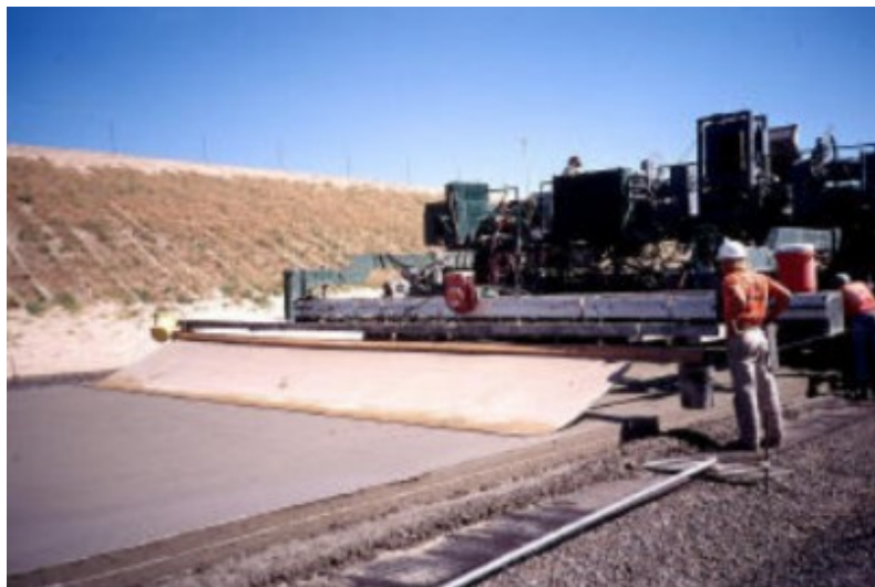
شکل 4- فرآیند و تجهیزات مورد نیاز برای ایجاد بافت درشت به وسیله کشیدن پارچه کرباسی
