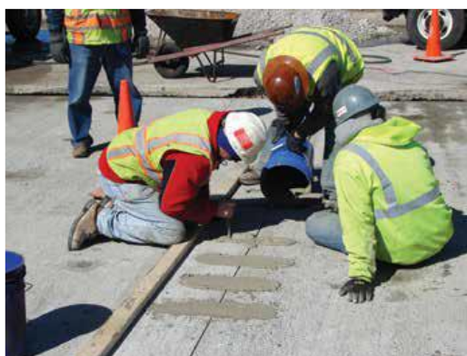
شکل ۱- مقاوم سازی با میله‌های پرچ شده
