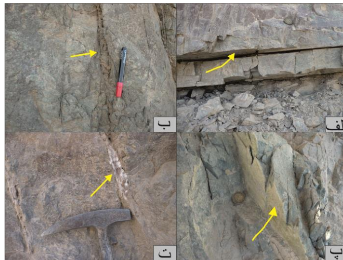
شکل ۴. ویژگی سطح درزه، الف: درزه فاقد پرشدگی، ب: درزه پرشده با مواد آواری، پ: دگرسانی سطح درزه (کلریتی شدن) و ت: پرشدگی سطح درزه با کلسیت ثانویه
