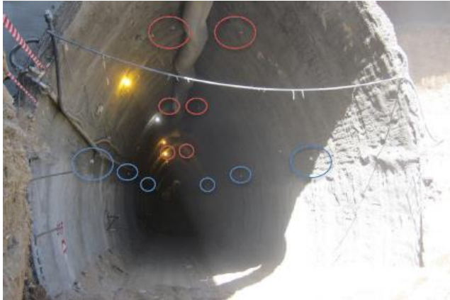
شکل ۱۱. تارگت‌های ژئودتیک استفاده شده در تونل حکیم
