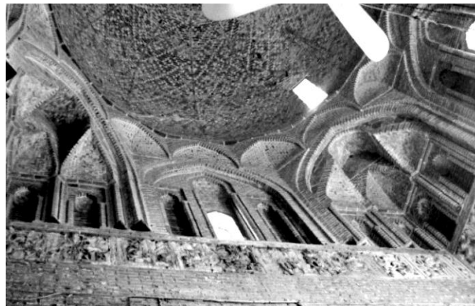
شکل ۵: چپیره سازی پتکانه در ناحیه زیر گنبد مسجد جامع زواره
