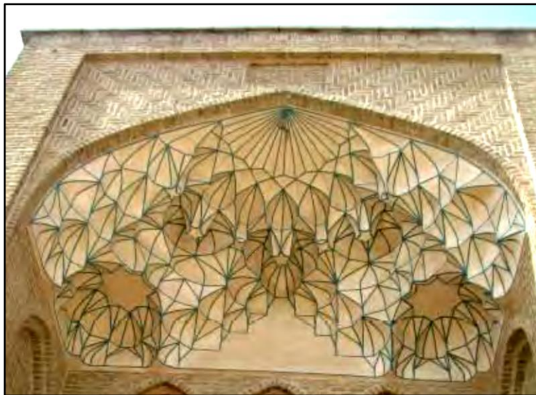
شکل ۷-مقرنس کاری در ورودی اصلی از کاروانسرای پیام (منبع نگارندگان).
