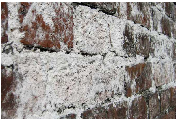
شکل (۴). نمایی از شوره (سفیدک) بر روی آجر
