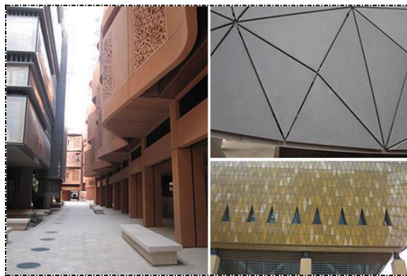
شکل ۹. بخشی از مصالح به کاررفته در نمای بناهای انستیتو تکنولوژی شهر مصدرسیتی
