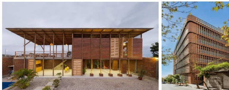
شکل 3- ساختمان پیلوتی و ساختمان متخل در تهران
