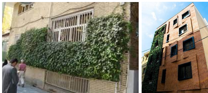
شکل 4- عایق اکولوژیکی ساختمان در تهران
