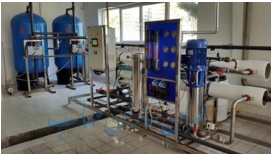
شکل ۱. واحد تزریق اسید سولفوریک.
