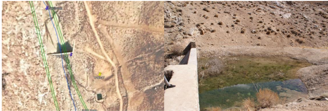
شکل (۲) تجمع آب و رسوب در پشت سد سنگی ملاتی فاقد روزنه (سمت چپ) لجنی شدن وعدم نفوذ آب تجمع یافته در بالادست سدهای سنگی ملاتی و بستر گرانیتی و به دنبال آن تبخیر و هدر رفت بیش از مقدار نفوذ (سمت راست)
