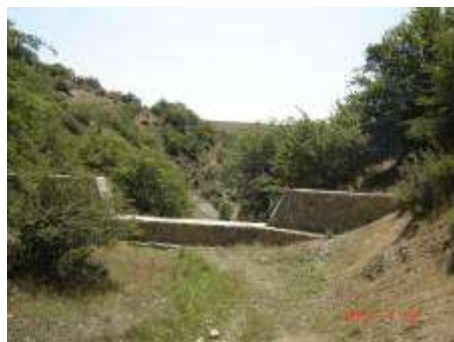
شکل ۳: سازه مکانیکی احداث شده در آبراهه زیرحوضه O3
