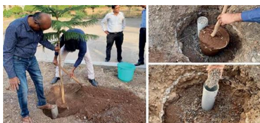
شکل ۲- تکنیک ستون ماسه و نحوه قرارگیری آن در خاک
