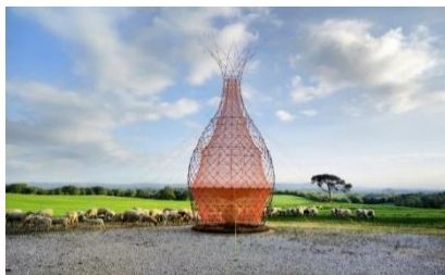
شکل ۸- نمونه‌ای از جمع‌کننده مه به شکل برج
